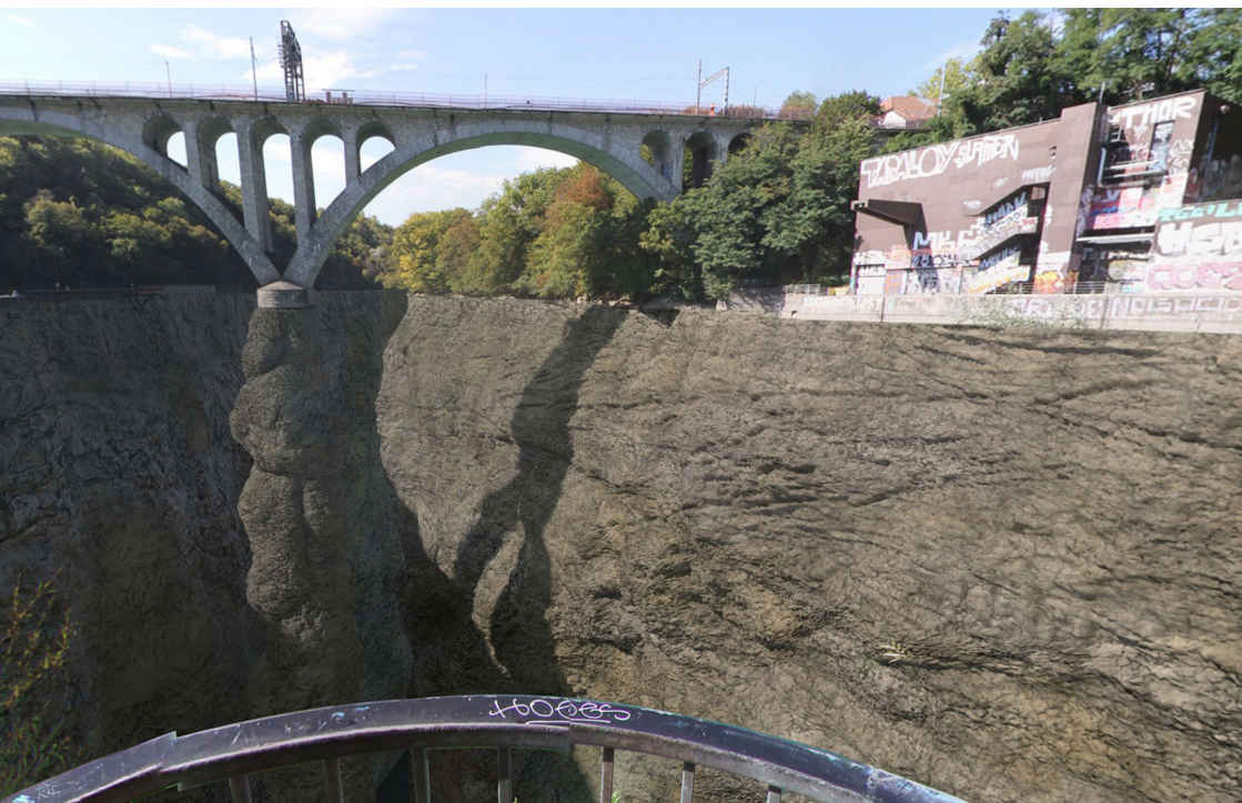
Le pont de la Jonction comme si le Rhône et l'Arve étaient au niveau de la mer.
